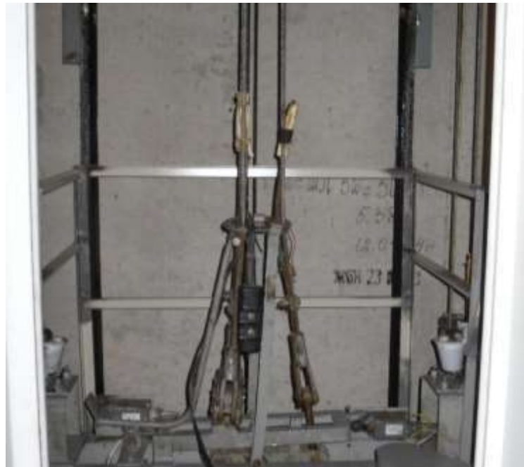
ПОДЪЕЗД № 1. Лифт Рег. № 156023 Произведена установка ограждения кабины
